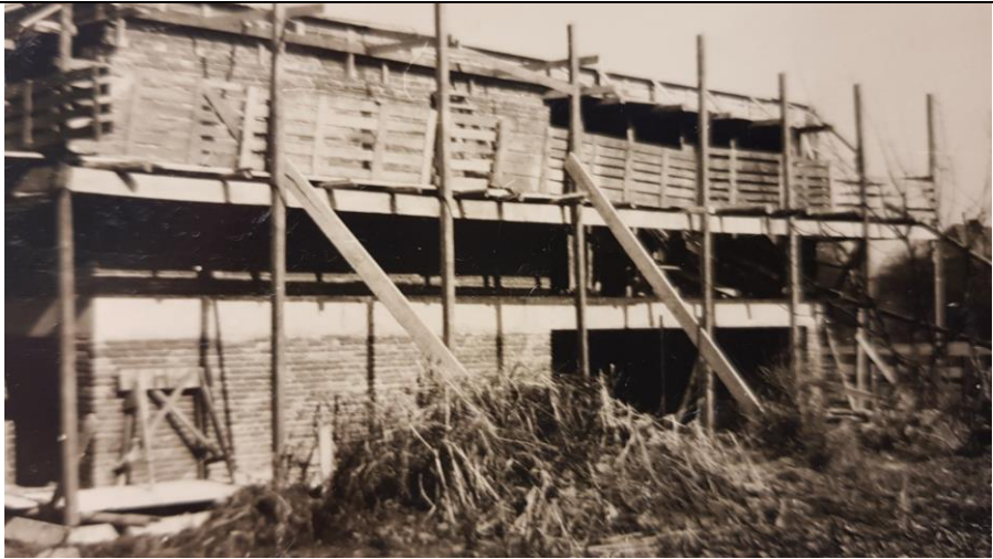
Abb. 35: Bau des Gemeindeshauses zwischen Juli 1962 – 15.12.1963 (mit mehreren Fotos von Ehrhard Rothacker)
