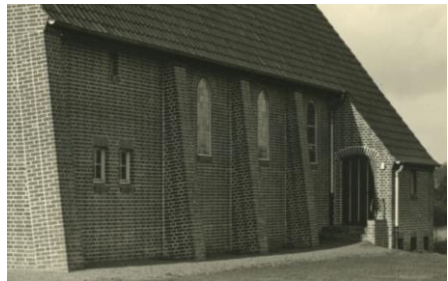
Abb. 28: Architektonisch begründbar boten die massiven Stützen den Eindruck einer Wehrkirche
