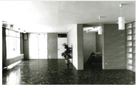
HAA_ORh_008.24_(0242) Nach dem Totalumbau 60 durch H&J 1962ff: Ergänzung von Gemeindehaus und Turm
